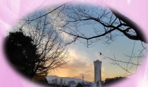
本社鎌水近くの浄水塔の夕焼け
